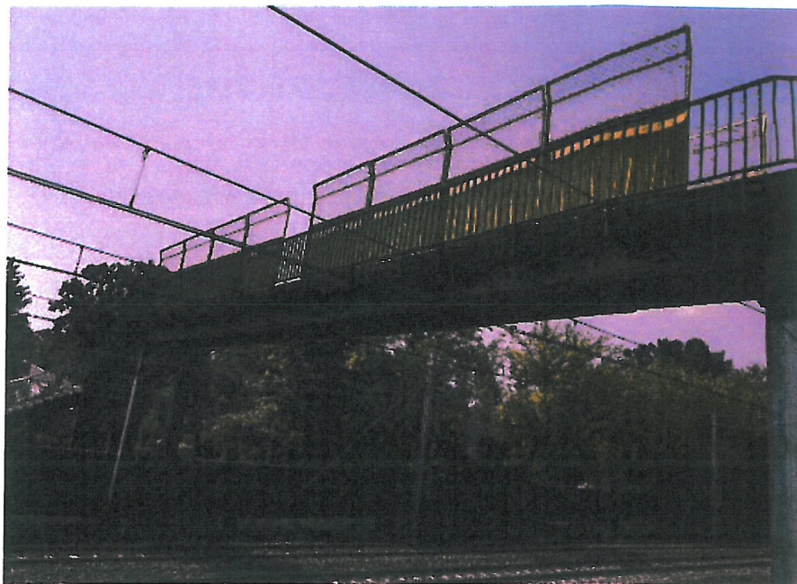
Rys. 2. Widok obiektu od strony wschodniej
