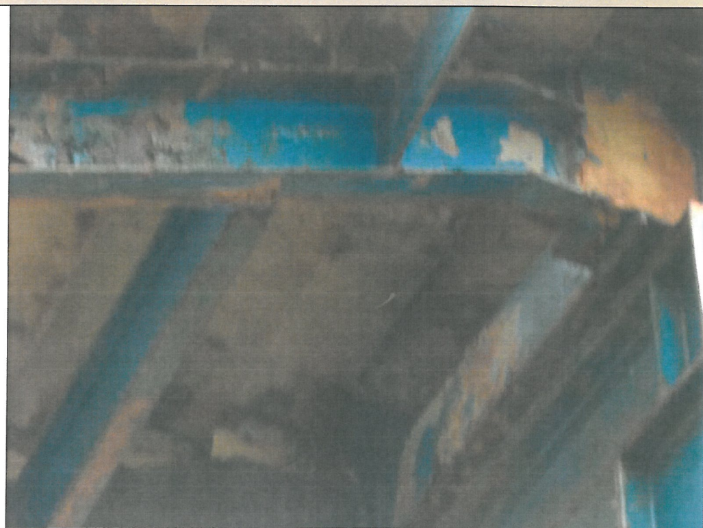
50. Korozja elementów
