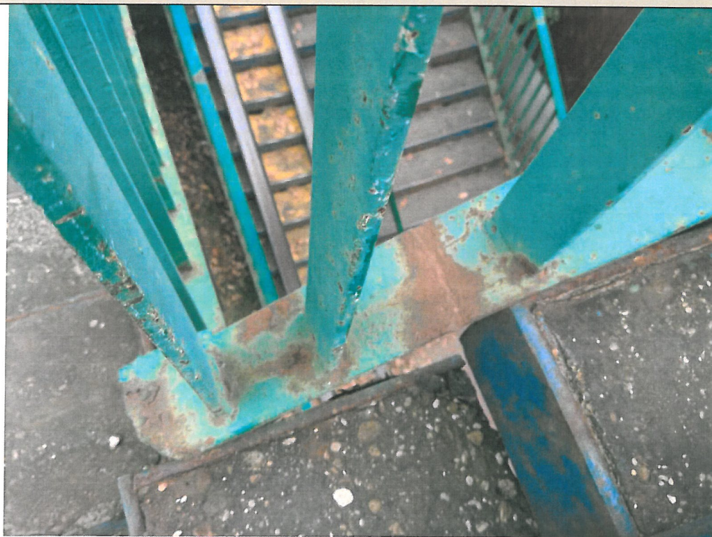
22. Korozja elementów
