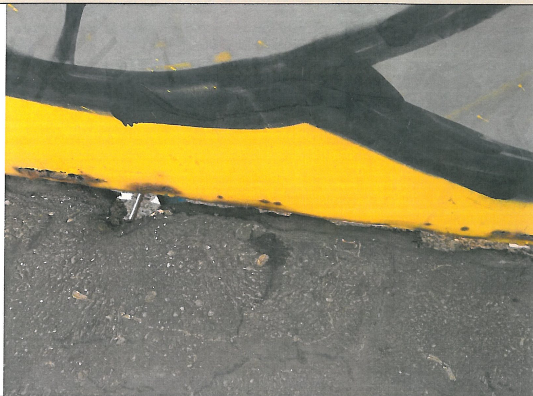
26. Ubytki asfaltu
