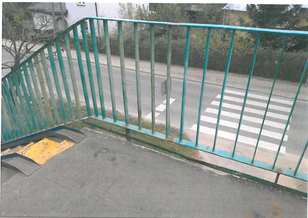
29. Korozja elementów
