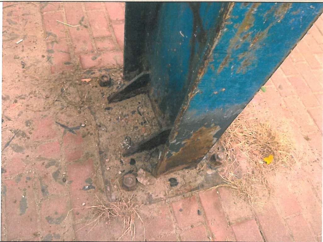
46. Korozja elementów
