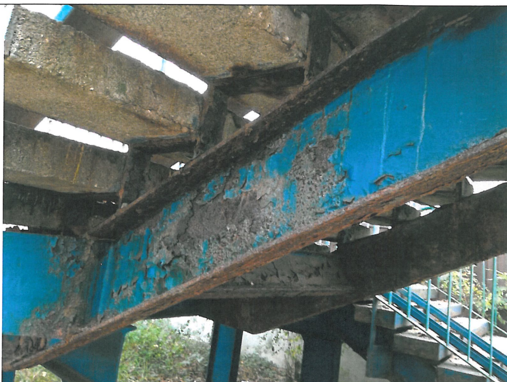
11. Korozja elementów
