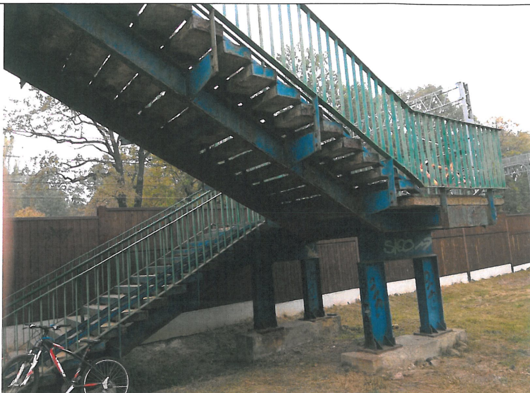
41. Korozja elementów
