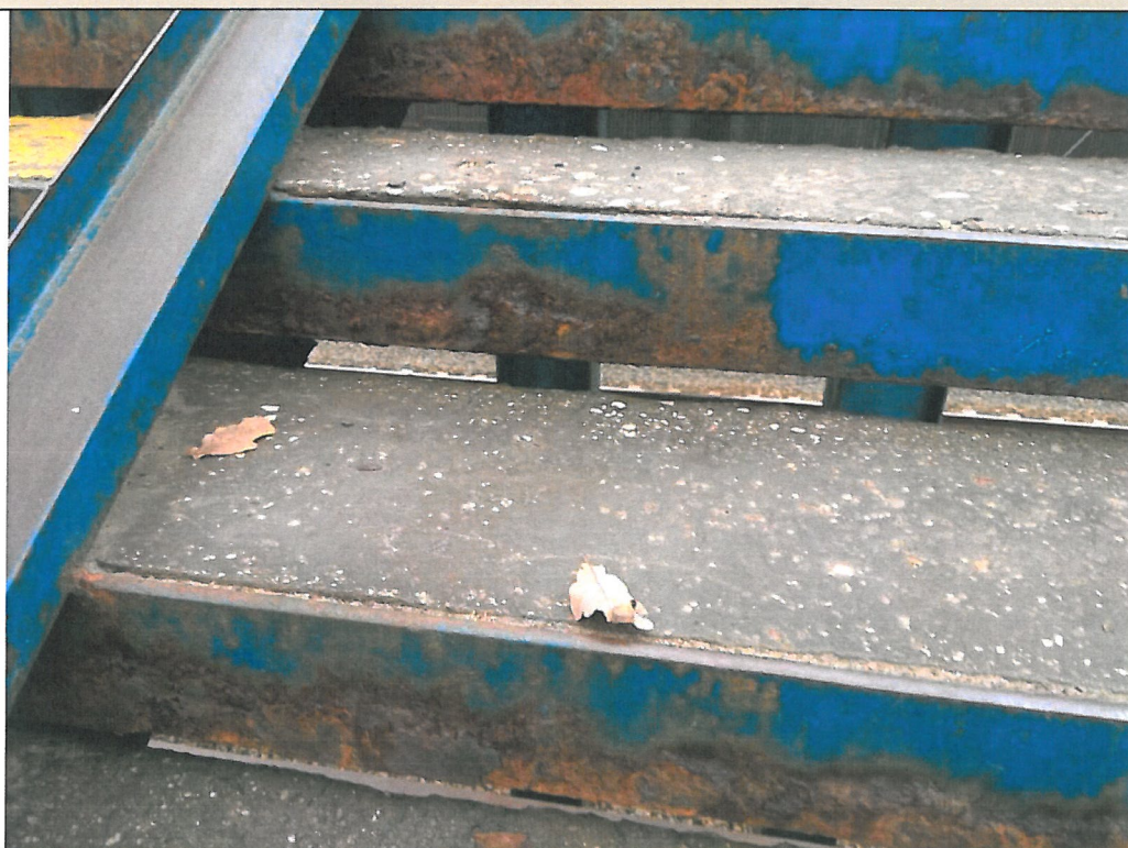
20. Korozja elementów
