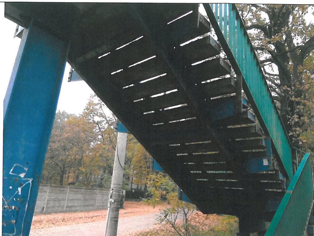
7. Korozja elementów
