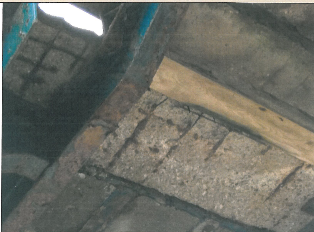
38. Korozja elementów
