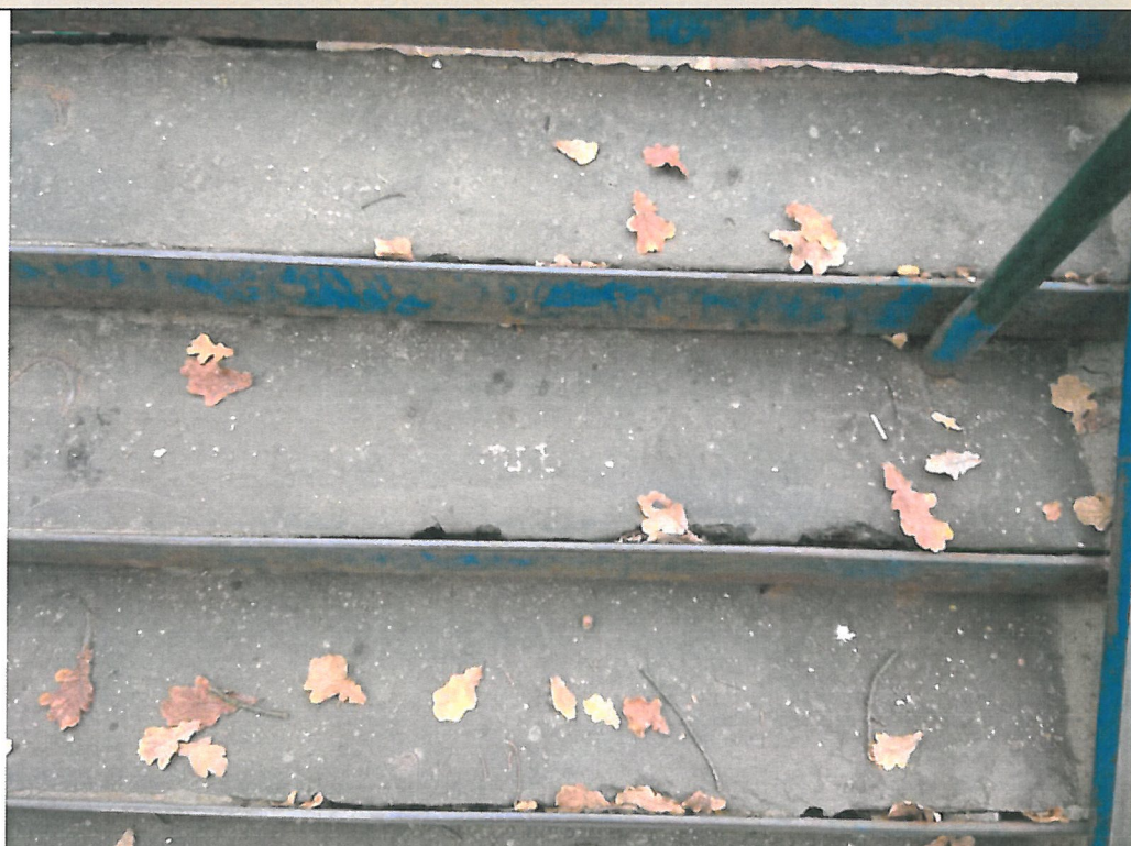
15. Ubytki betonu i asfaltu Korozja elementów
