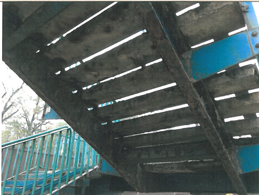
44. Korozja elementów
