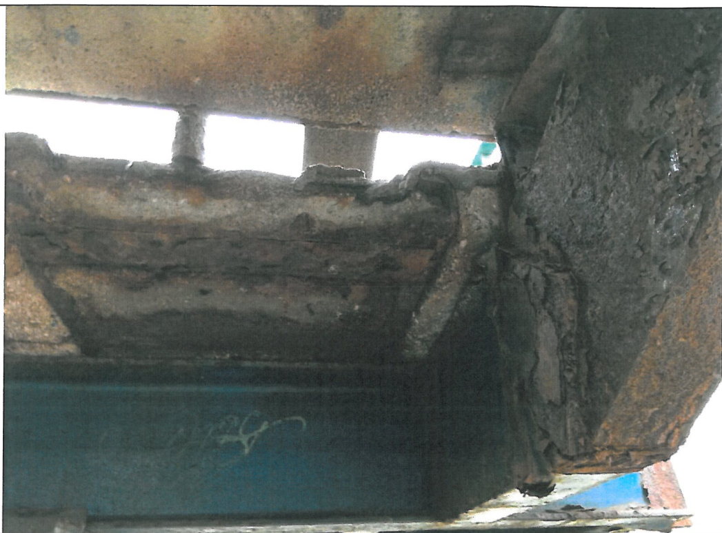
45. Korozja elementów
