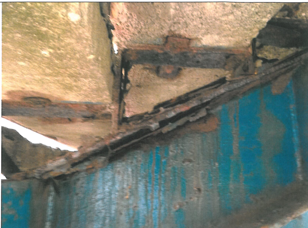
43. Korozja elementów
