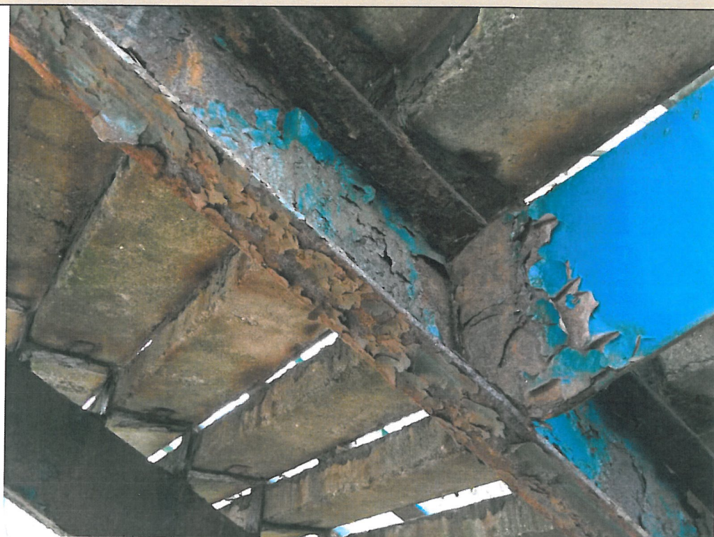
8. Korozja elementów
