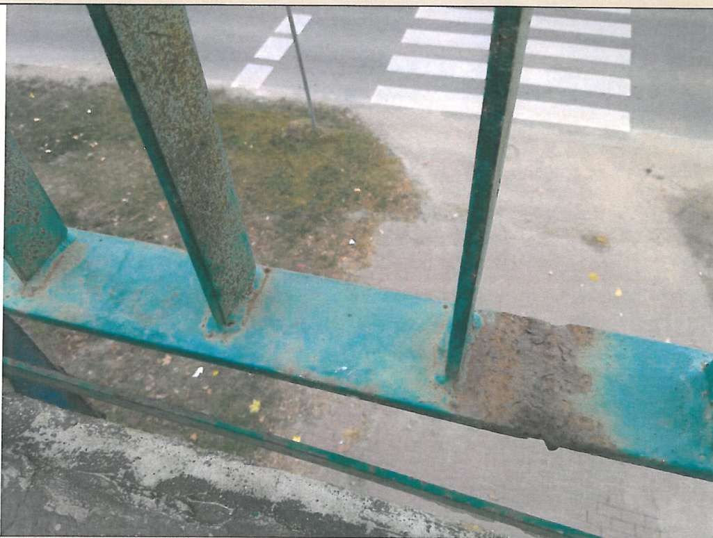
30. Korozja elementów
