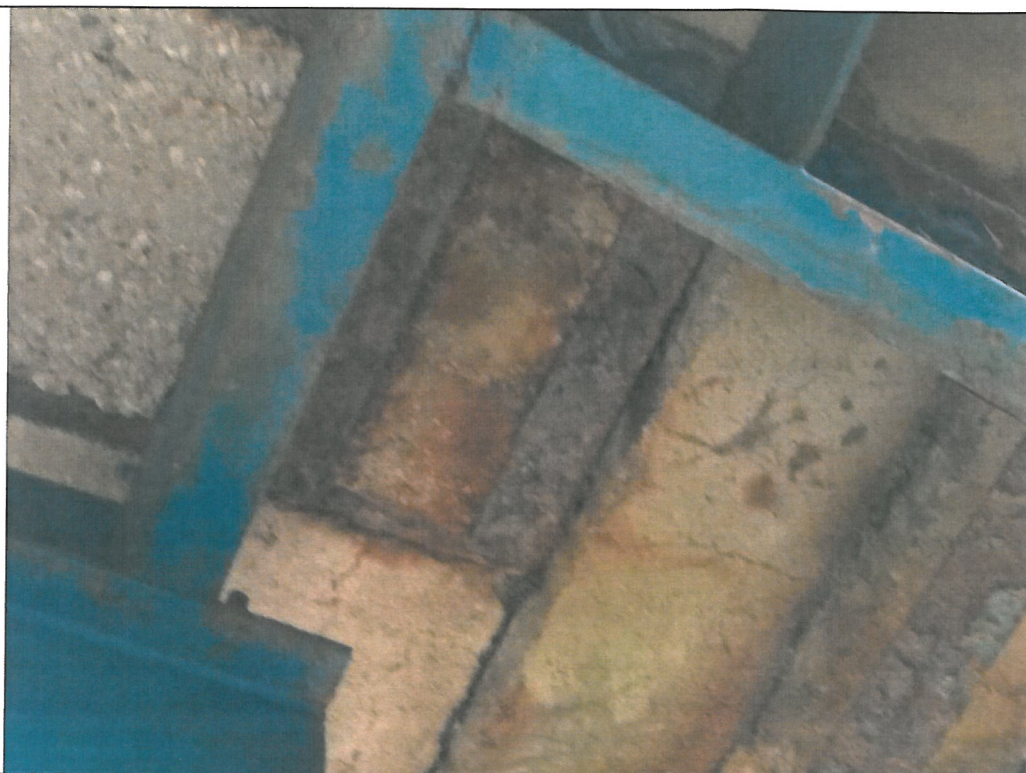
13. Korozja elementów
