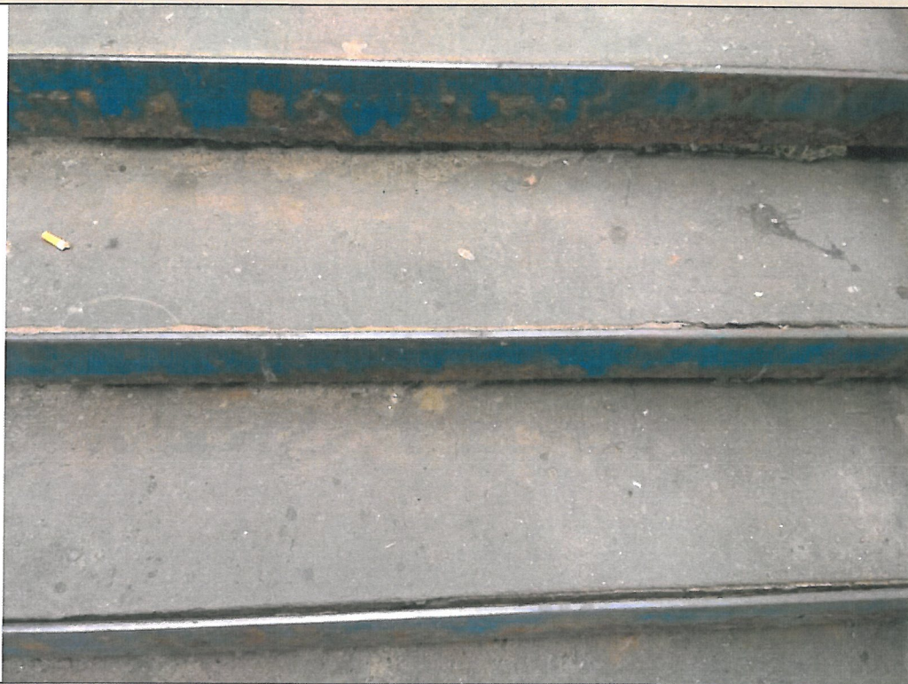
34. Korozja elementów
