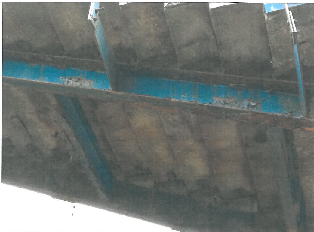
47. Korozja elementów
