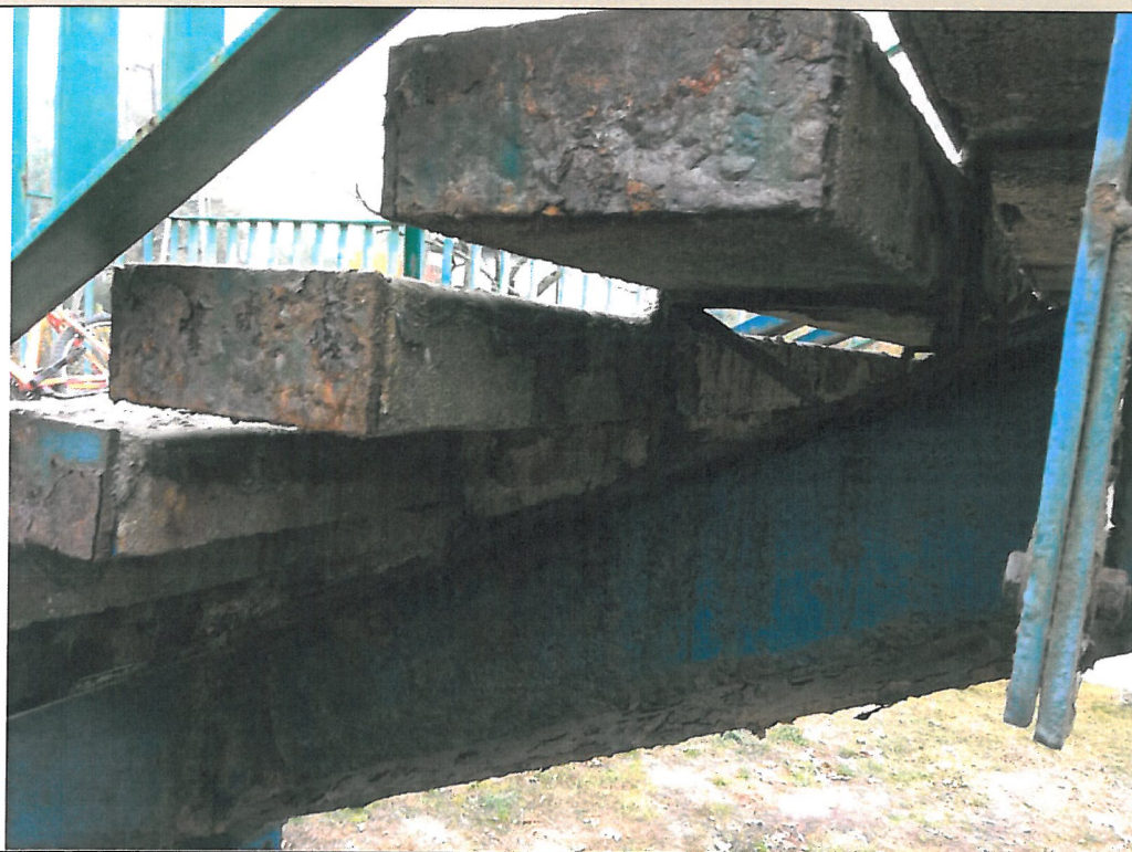
36. Korozja elementów
