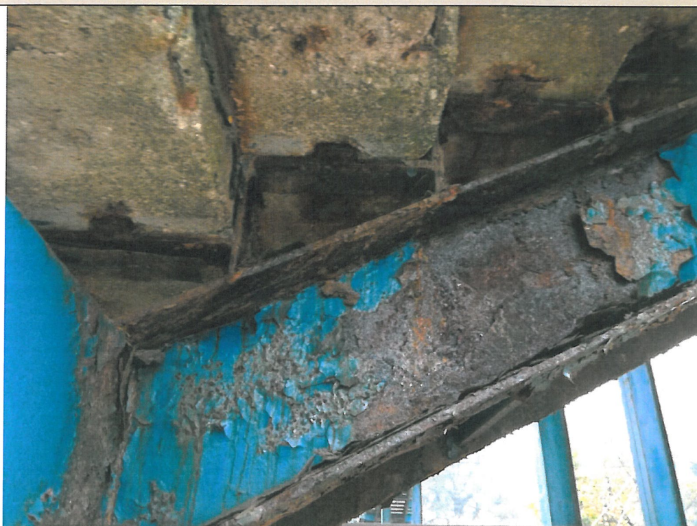
10. Korozja elementów
