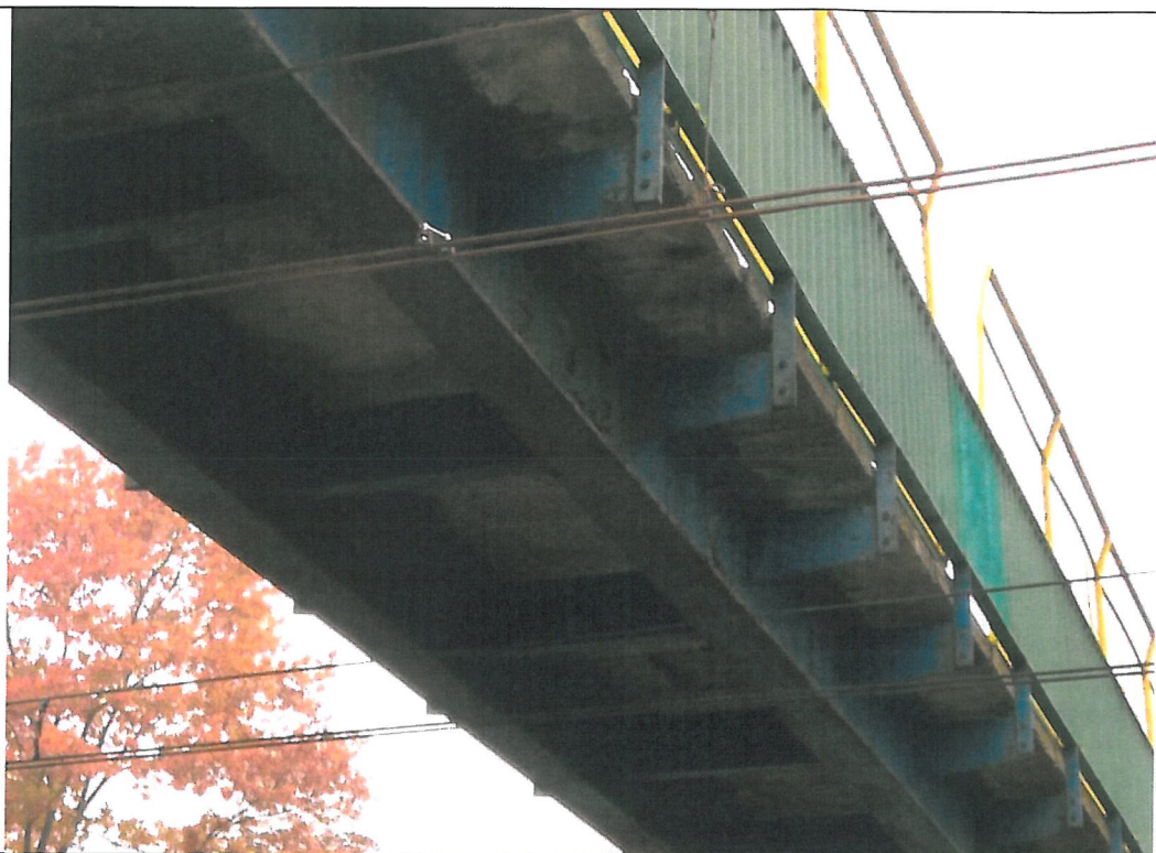
49. Korozja elementów
